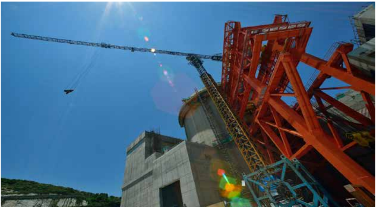
图 3.4-2 阳江核电厂现场施工图
