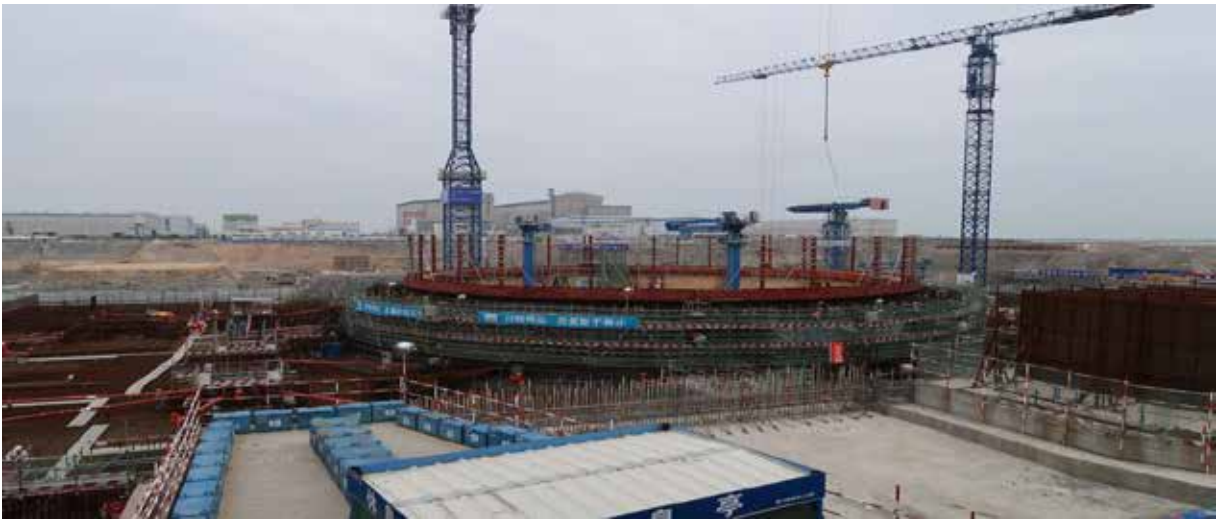
图 3.9-2 防城港核电站工程现场
