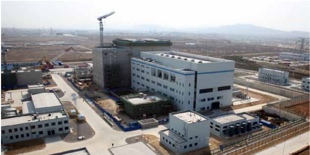
图 3.10-2 石岛湾核电厂高温气冷堆核电站示范工程
