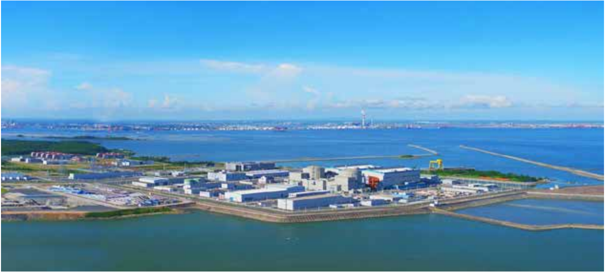
图 3.9-1 防城港核电站全景图
